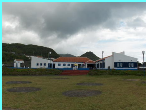
Grande intervenção na recuperação da Zona Balnear da Fajã Grande
