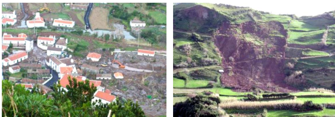
Figura 65. Movimentos de vertente na Fajãzinha (esquerda – 2010/12/02) e Lajedo (direita – 2012/10/30) (Fonte: PMEPC, 2018)
